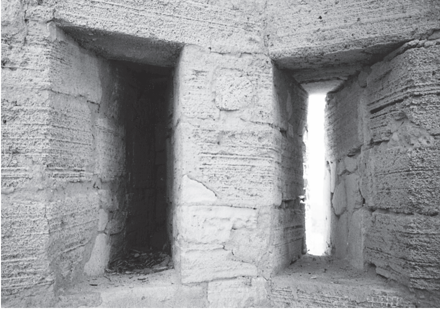
Doble espitllera, una d'elles aparellada per l'adossament d'una torre. (Foto: Pau Cateura.)
